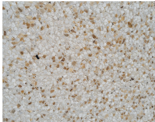
Piso Atérmico Hard Polido Branco com Pedra Palha
